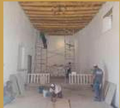
Colocación de piso.
