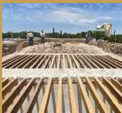
Colocación de vigas.
