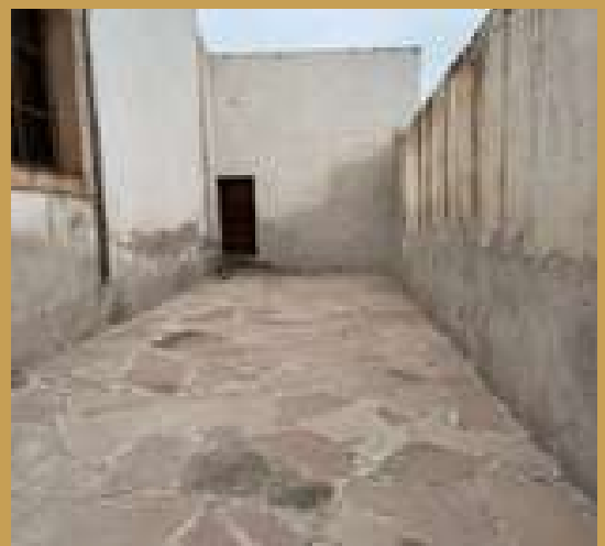
Detalle de piso en patio lateral derecho.
