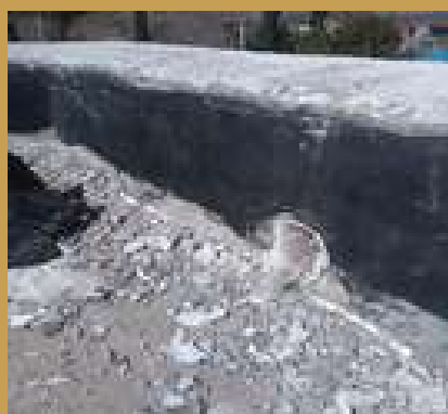
Retiro de capa de impermeabilizante.
