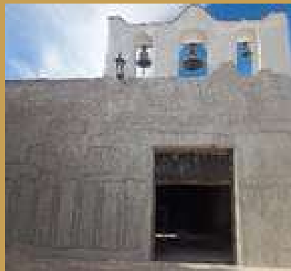
Aplanados en exterior.
