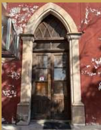
Antes de la restauración.
