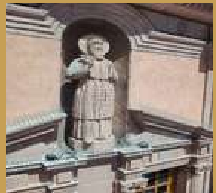
Instalación de mallas para cubrir detalles.
