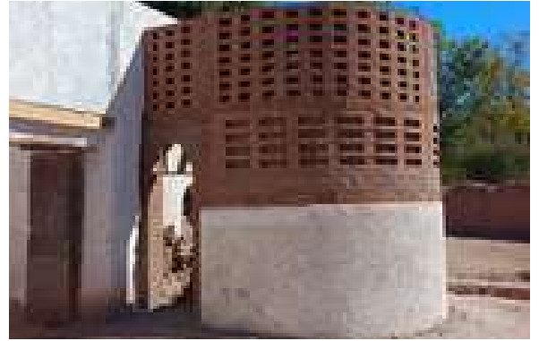
Avance en torreón.
