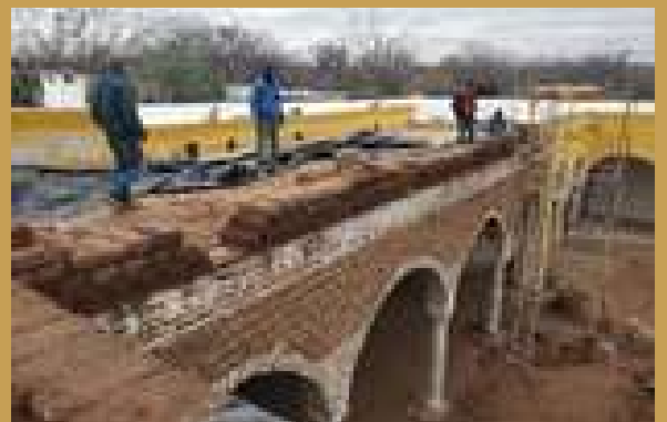
Avance en pretils.
