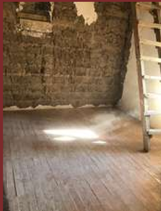
Colocación de piso.
