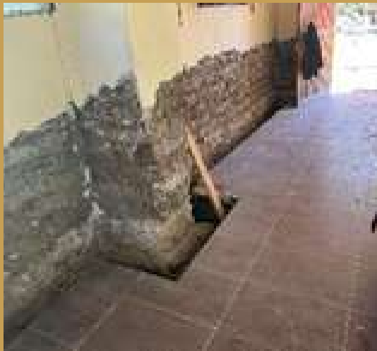
Inicio de obra
