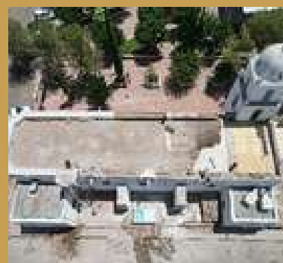
Colocación de terrado.
