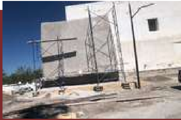
Aplanados en exterior.
