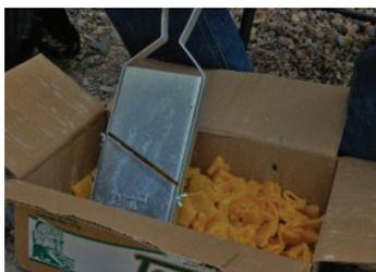
**Imagen 11.** Trabajando en el rayado del jabón para ponerlo a hervir dentro de la primera fase de la impermeabilización con jabón y alumbre que se aplicó en los templos de Aldama.
