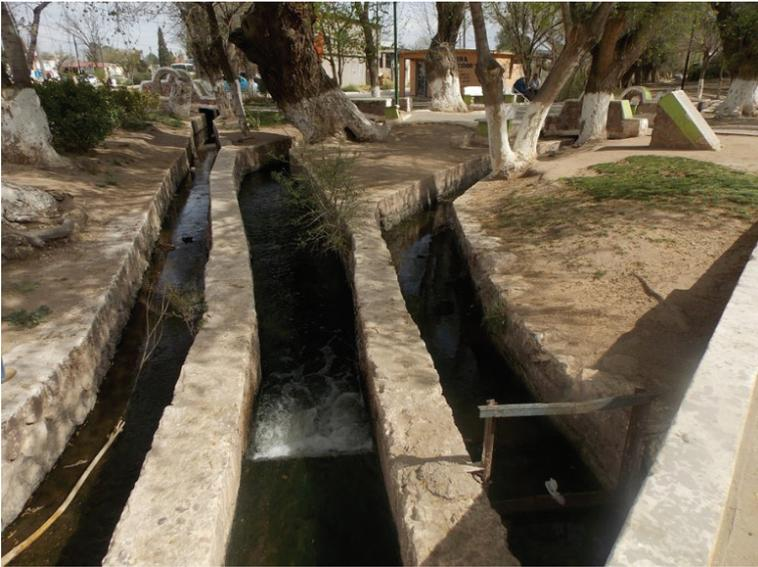
**Imagen 3.** “El Repartidor”, distribuidor hídrico que da lugar al sistema de acequias virreinales de Ciudad Aldama.
