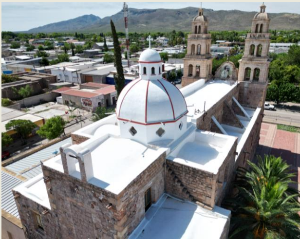
Vista de cubierta.
