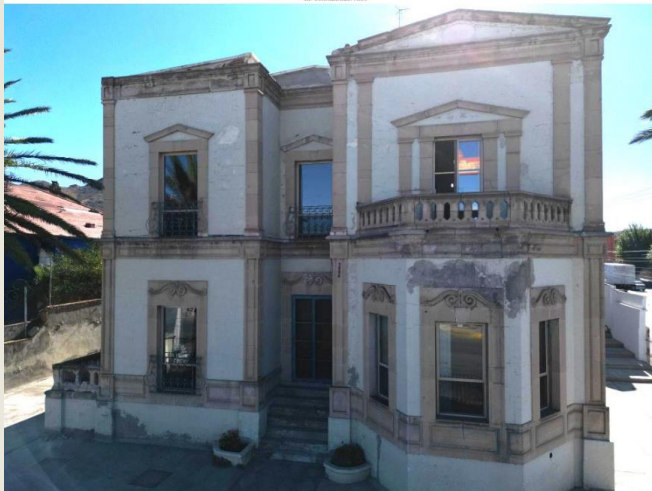
Fachada principal de Casa González Muzquiz, antes de la intervención.
