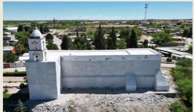
Intervención en la fachada norte.
