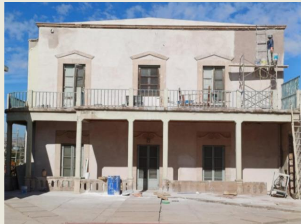
Colocación de aplanados en fachada posterior.
