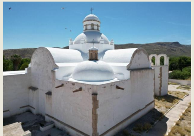
Cúpulas y bóvedas con mortarFine e impermeabilizante.
