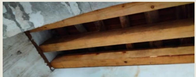
Consolidación de la torre, con la integración de nuevas vigas transversales.
