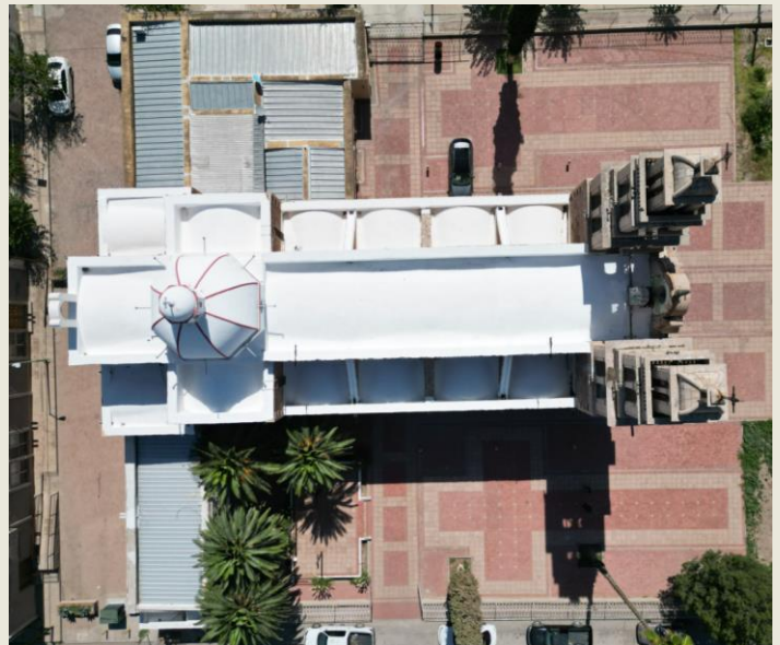
Vista de cubierta.
