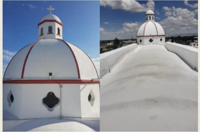
Impermeabilización de las Bóvedas y pintura de la cúpula.
