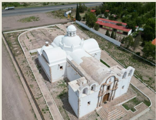
Vista aérea de obra en progreso.
