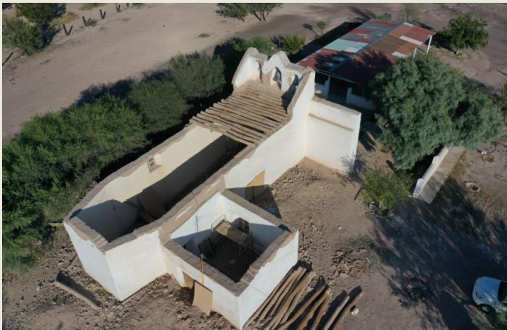
Desmantelamiento de cubierta.
