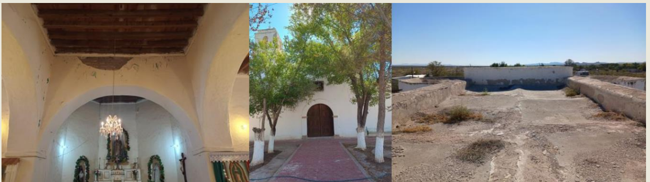
Fotos del estado actual de la capilla de San Fernando.
