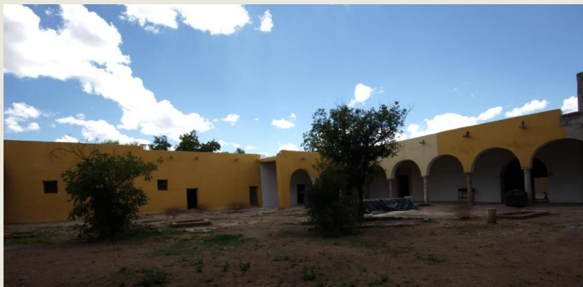
Cierre de la obra de la etapa II.
